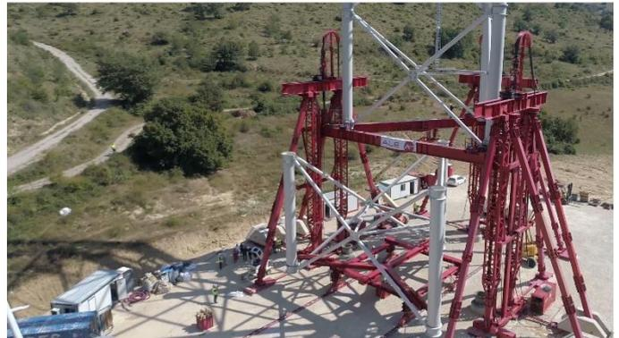
Esta idea primigenia pronto dio lugar a **otro modelo de negocio: ¿por qué no tratar de utilizar esta solución con las torres existentes en la actualidad?** Así surgió **la torre híbrida Nabralift**, que monta el **aerogenerador completo**, incluso con el rotor, sobre una torre tubular convencional que, posteriormente, se auto-iza hasta conseguir la altura deseada. Había surgido una nueva patente.
